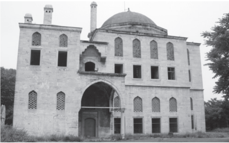
Fotoğraf 2: Hünkâr Kasrı restorasyon öncesi, Güney cephesi
